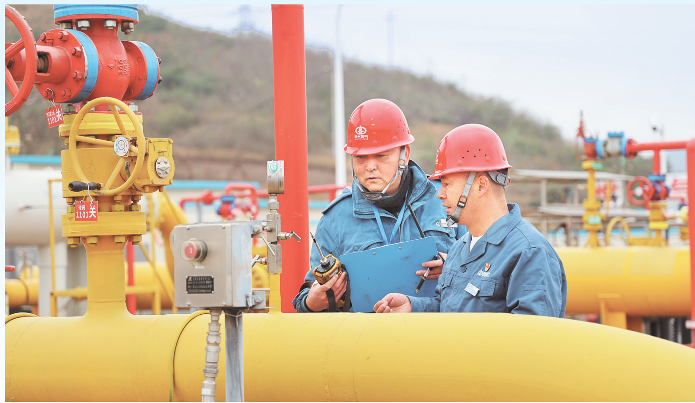
工作人员检查供气管道。
