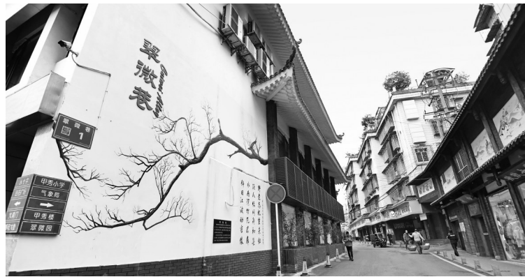
改造提升后翠微巷道路两侧围墙墙面。
