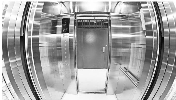
中华南路街道办市府路老旧小区加装增设了便民电梯。
