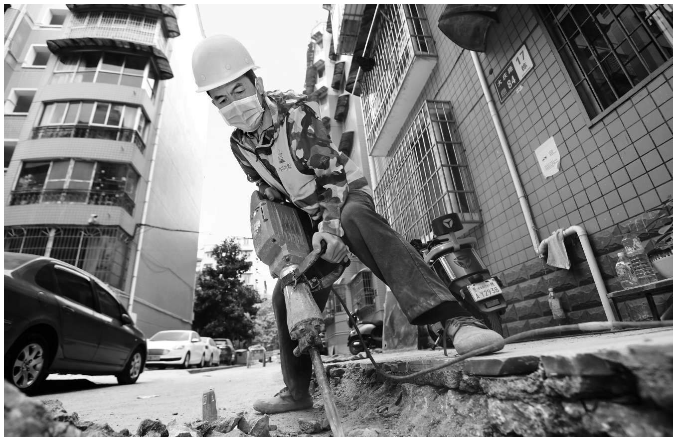
施工工人在大理石路片区老旧小区改造项目中使用电镐破除旧地面。
