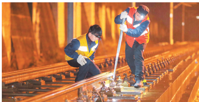
1月16日深夜至17日凌晨，沪昆高铁贵州铜仁南站铁路民警和线路工区工作人员对站内设备安全等进行全面排查巡检，保障春运期间铁路运输安全。图为铁路工作人员在进行设备巡检。 胡攀学 摄 贵州图片库发
